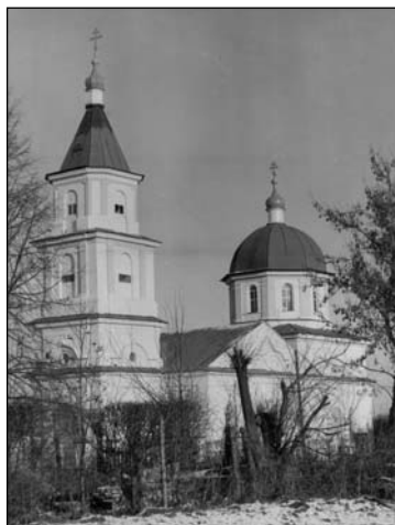
Церковь Преображения после ремонта в 1986 году
