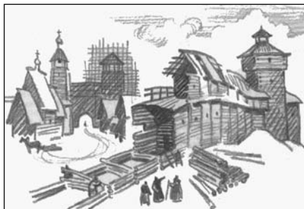
Строительство стен древнерусского города
