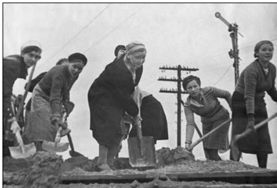
На строительстве оборонительных сооружений
