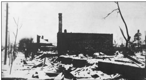
Разрушения на ул.Горького в результате бомбардировки 28 ноября 1941 года
