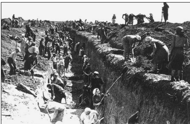
Строительство оборонительных сооружений на подступах к Москве
