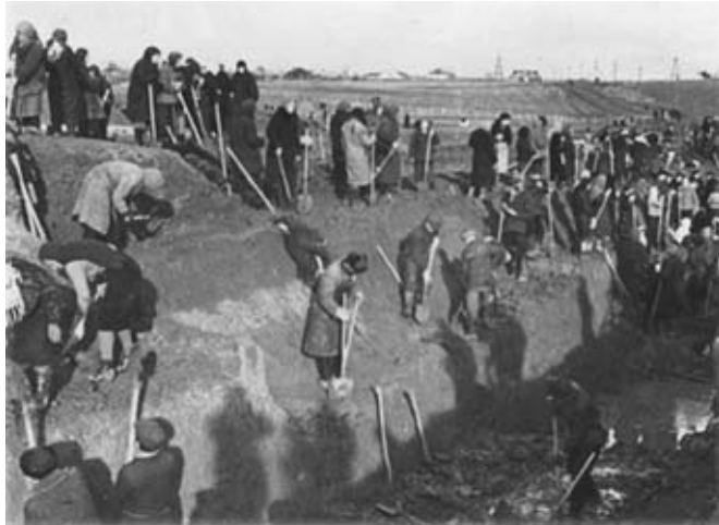
Строительство оборонительных рубежей в Московской области
