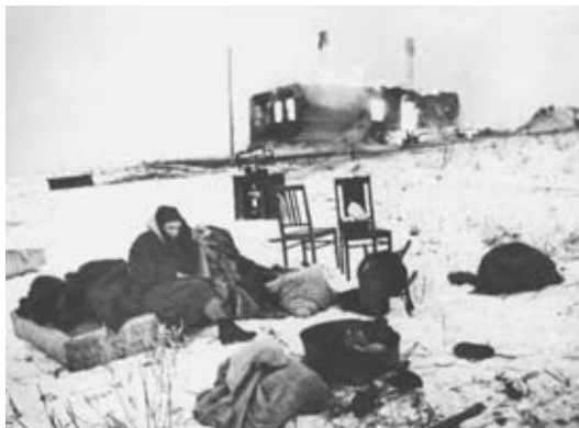
Волоколамское направление. У разрушенного дома
