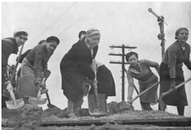
На строительстве оборонительных сооружений
