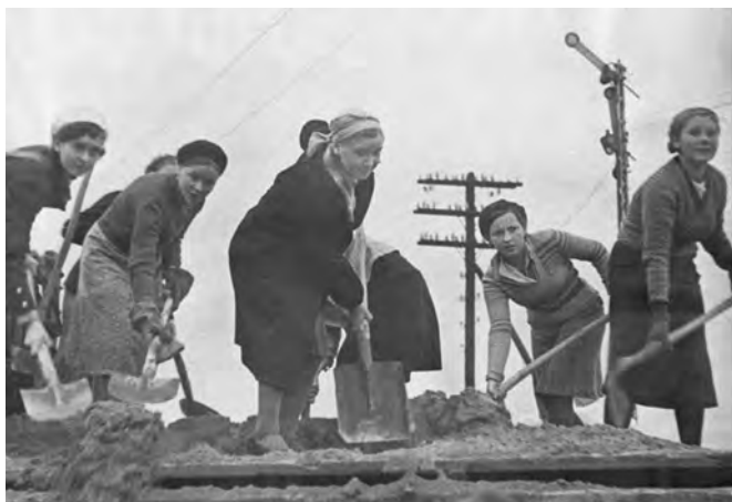
На строительстве оборонительных сооружений
