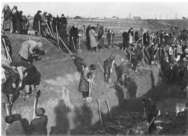
Строительство оборонительных рубежей в Московской области
