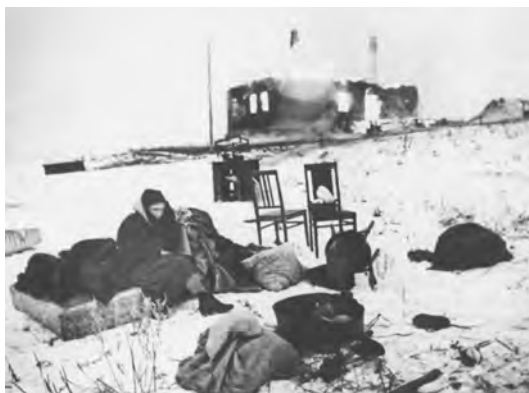
Волоколамское направление. У разрушенного дома
